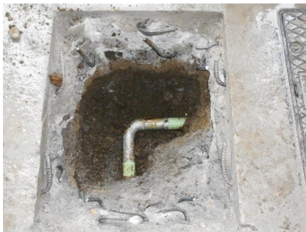
埋設配管の掘削状況
