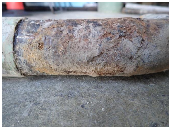
防食テープを剥がした配管表面の状況
