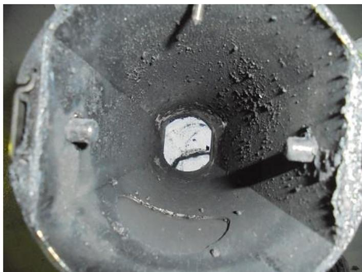
写真5-12 鎮火後、ダクト内部の状況（着火有）
