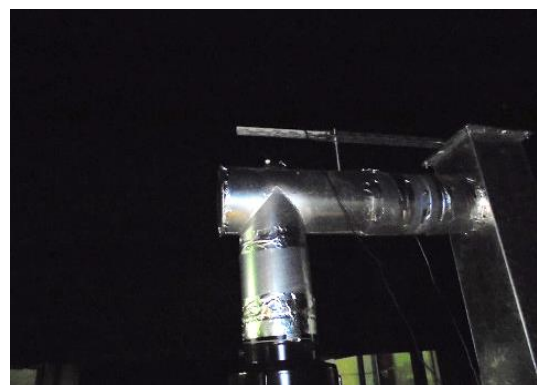
写真6-92 上引きダクト内部へ カメラ設置
