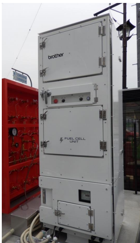
図 3.1.2-9 岐阜県八百津町 防災センター 5kW 級機
