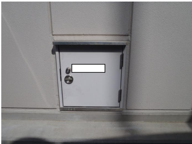
写真7-14 ハト小屋点検口の例
