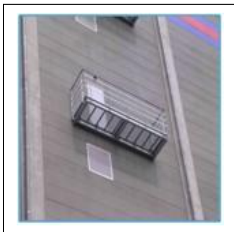
写真7-1 非常用進入口
