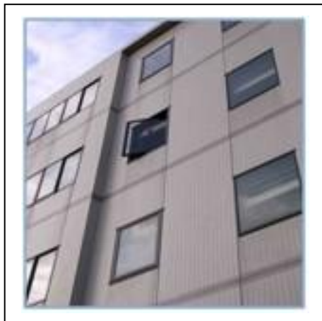
写真7-2 非常用進入口（代替開口部）
