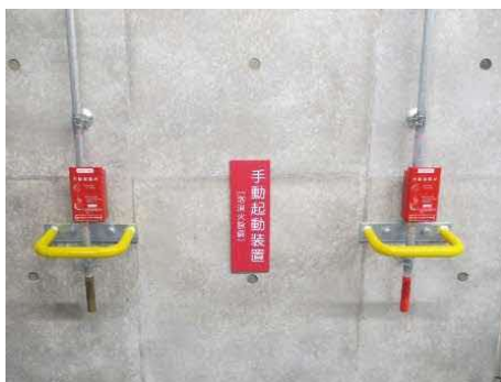
手動起動装置に保護ガードを設置
